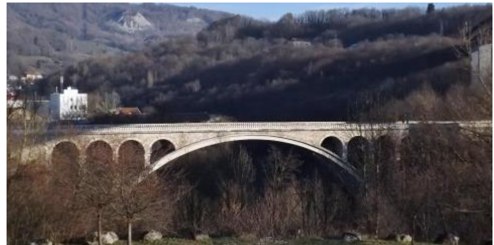
Pont de Savoie (1948) – Coignet SA – (Crédit : Florian Pépelin)
