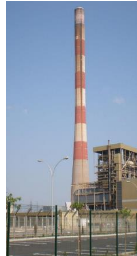
Cheminée de 245 m de la centrale d'Aramon (Crédit : EDF)
