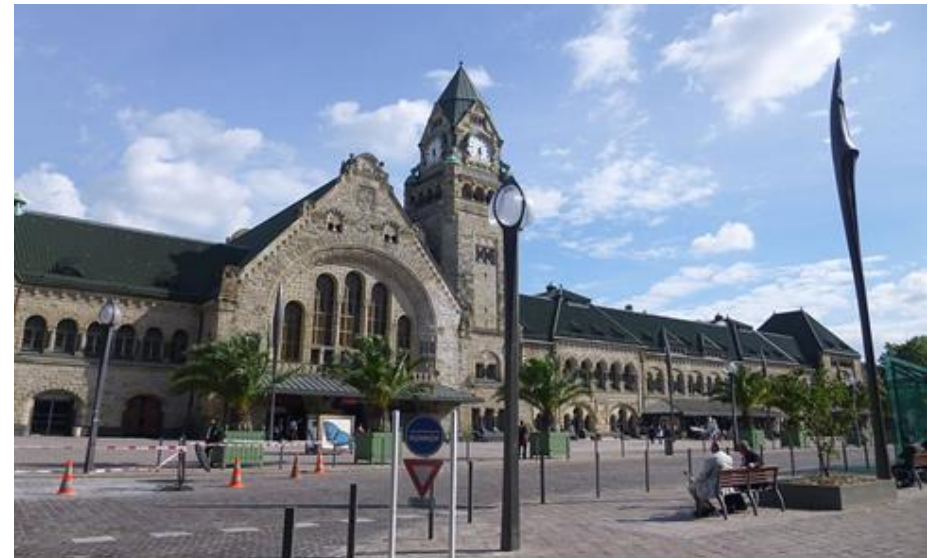
Metz. Gare ferroviaire. 1908. Monument historique
