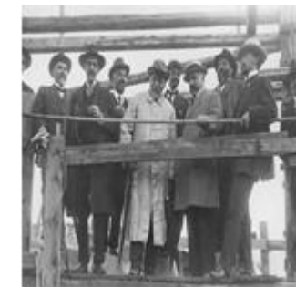
Hennebique (au centre) sur le chantier
