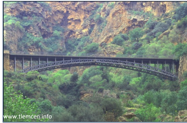
2. Viaduc d'El Ourit (Pont des cascades), entre Sidi-Bel-Abbes et Tlemcen (Ouvrage Eiffel en service)
