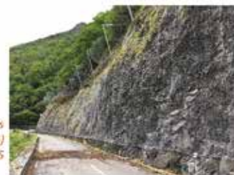
Protections de paroi Rocheuses Gorges de Luz (65) CD 65
