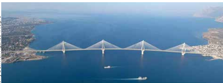
Le pont de Rion-Antirion, en Grèce construit par Gefyra/Vinci en 2004.
