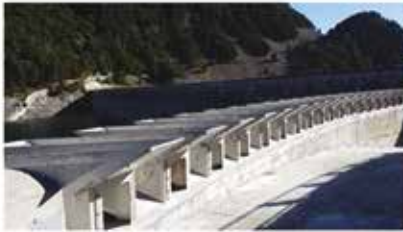
PKWEIR Métallique Barrage de l'Oule (65) SHEM
