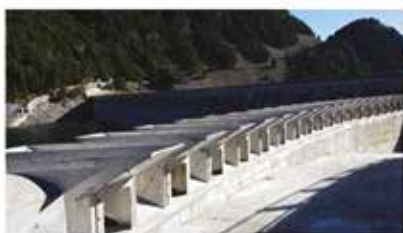
PKWEIR Métallique Barrage de l'Oule (65) SHEM
