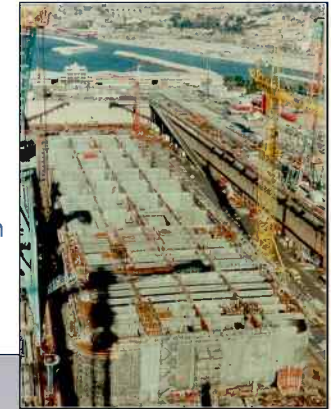
N'Kossa en construction
