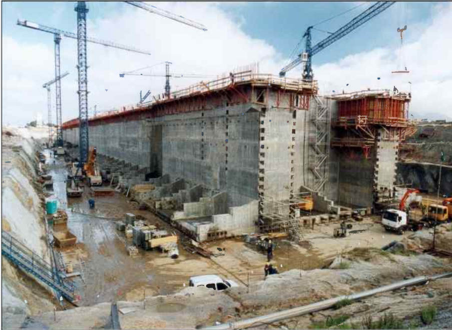
Construction du quai
