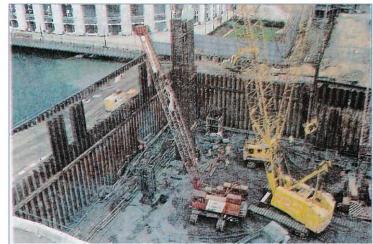
Station Canary Wharf. La plateforme à -8m
